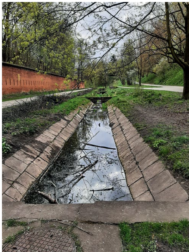
Drna, ujście pod ziemię
